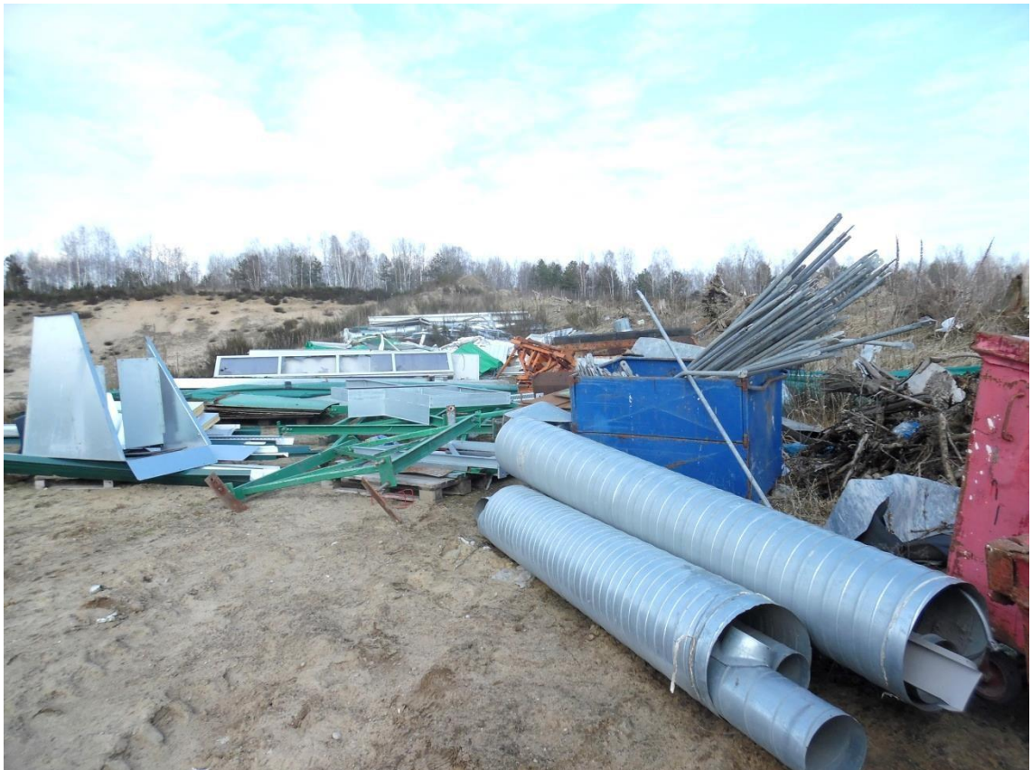
8. Zdemontowane elementy instalacji wentylacji (kanały wentylacyjne) z linii sortowniczej oraz inne elementy konstrukcji i wyposażenia obiektów
